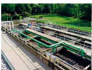
Dans le bassin d'aération, les micro-organismes naturellement présents dégradent les matières organiques. De l'air est insufflé pour activer le travail des bactéries.
